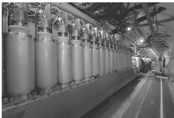
Rys. 18. Moduł połączeniowy energetycznych kabli zasilających poprzez nadprzewodniki wysokotemperaturowe z obwodami kriogenicznymi magnesów nadprzewodnikowych
