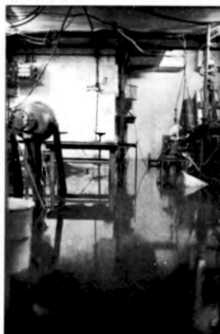
Rys. 8. Zalane wodą pomieszczenie eksperymentalne akceleratora – wynik gwałtownego opadu atmosferycznego.
