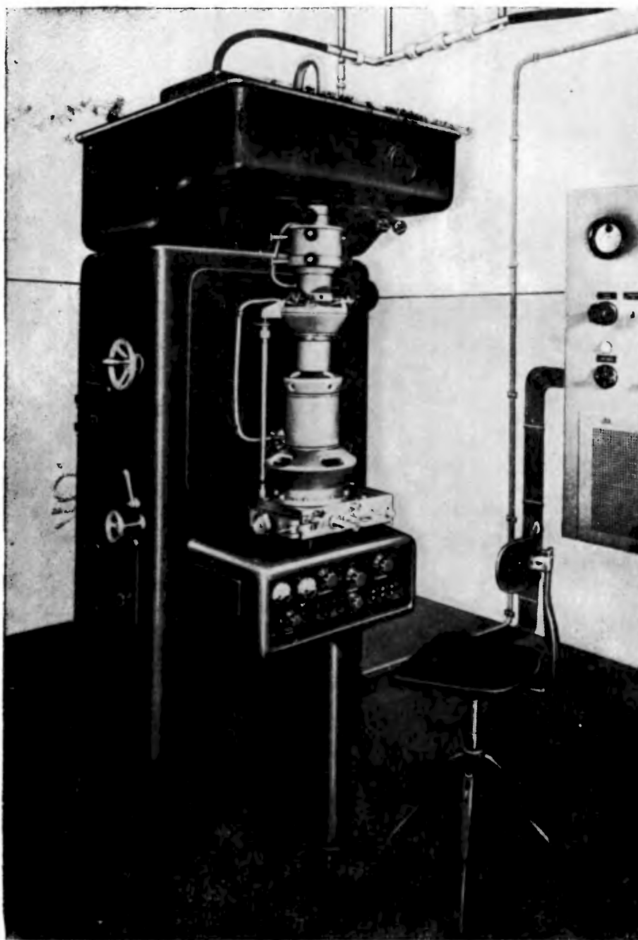
Rys. 11. Pierwszy mikroskop elektronowy produkowany seryjnie przez zakłady Siemens. Wygląd ogólny [21].
