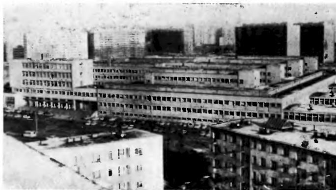
Ryc. 13. Kompleks budynków obecnej siedziby IF PAN przy Al. Lotników 32/46 w Warszawie
