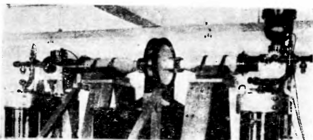
Rys. 5. Zdjęcie „kompresora II“ w trakcie montażu w Livermore
