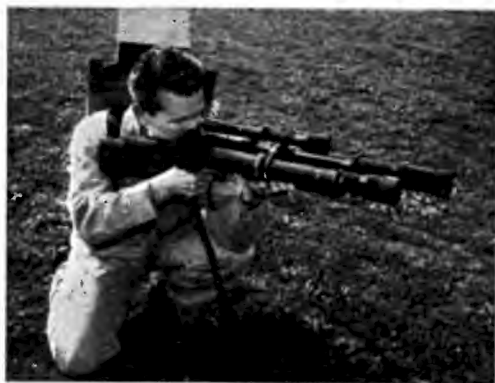
Rys. 3. Kolidar amerykański typu wojskowego (firmy Hughes). Aparat ma mocną budowę i jest przystosowany do łatwej obsługi przez jednego człowieka
