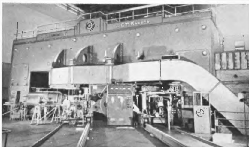
Rys. 4. Synchrocyclotron radziecki na 680 MeV
