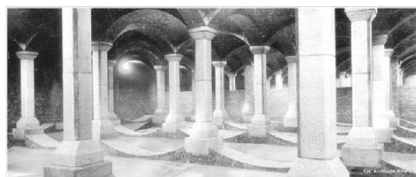
Ryc. 19. Stacja filtrów wody w Warszawie (NAC)
